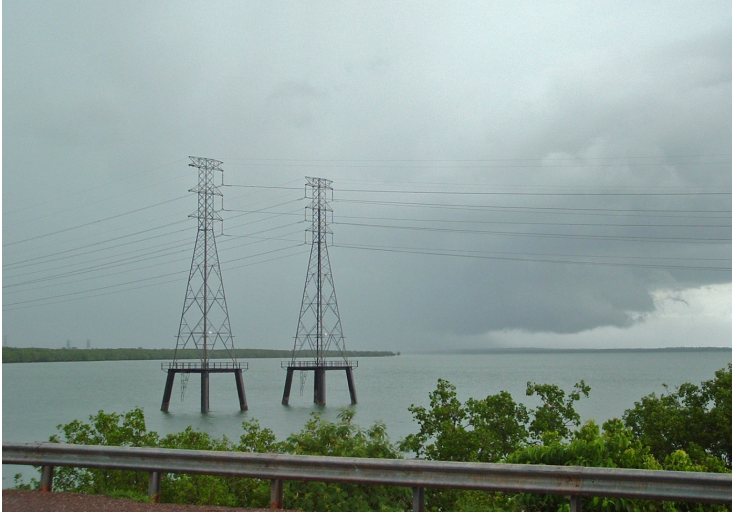
double-circuit 380kV
